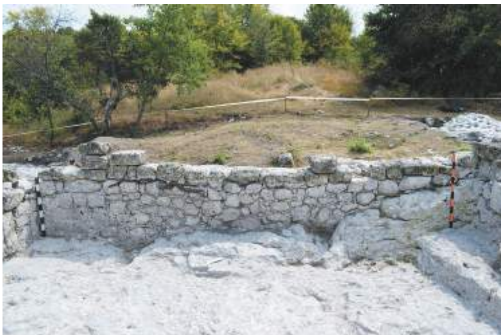
Илл. 45. Церковь Св. Георгия. Наос. Внутренняя фасировка южной стены храма. Фото 2016 г.
