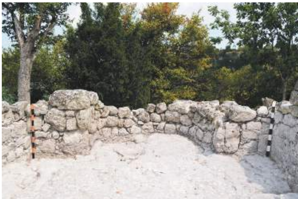
Илл. 44. Церковь Св. Георгия. Наос. Внутренняя фасировка восточной стены храма. Фото 2016 г.
